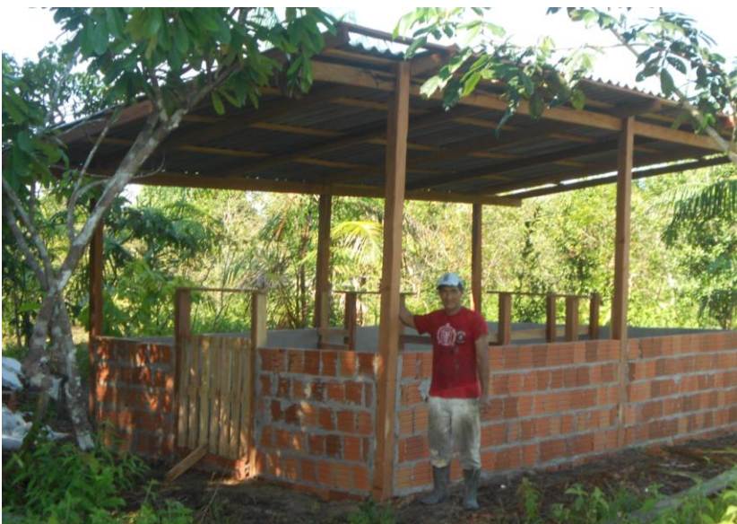
Ein fertiger Schweinestall.
