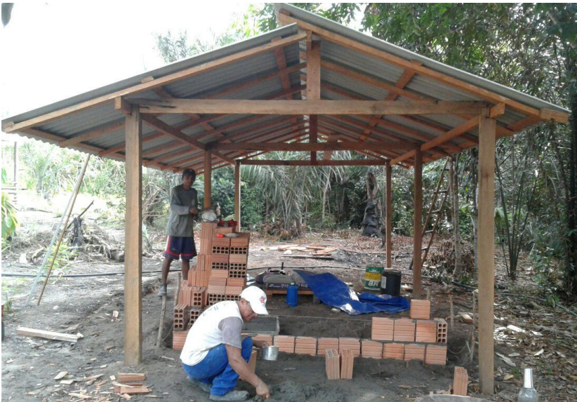
Eine Wurmfarm entsteht: Der Unterstand mit den Behältnissen wird gebaut.
