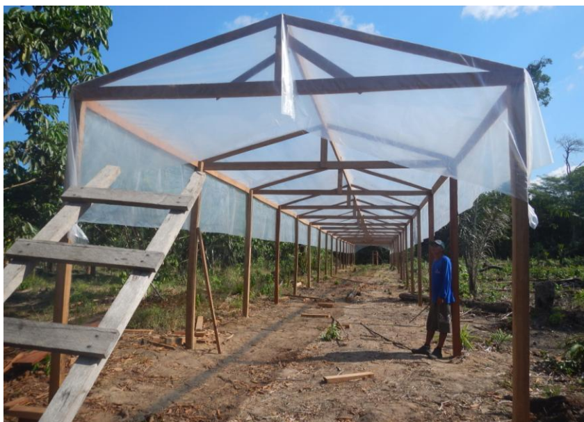
Die Pfosten werden verbunden und ein Giebel aufgebaut.
