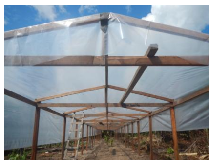
Die Konstruktion wird überdacht.
