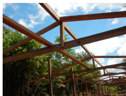
Die Pfosten werden verbunden und ein Giebel aufgebaut.
