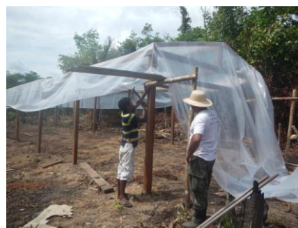
Die Pfosten werden verbunden und ein Giebel aufgebaut.
